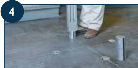
4 Les stabilisateurs de joints SD sont posés.
