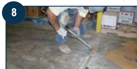
8 Des étapes supplémentaires de meulage, de remplissage et de finition peuvent s'avérer nécessaires pour compléter la réparation.
