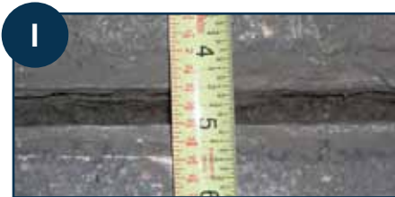
1 Examiner la dalle, la mesurer et noter la déflexion (facultatif), puis déterminer l'emplacement de la pose et des réparations.
