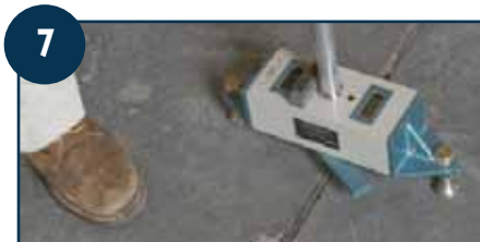
7 La déflexion est mesurée de nouveau pour confirmer la réussite de la pose (facultatif).
