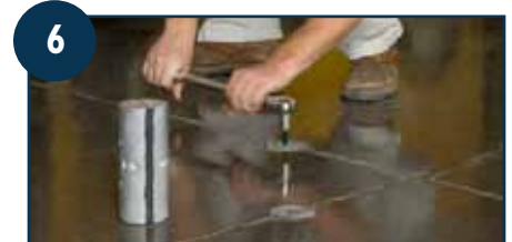
6 Les stabilisateurs de joints SD sont serrés à un couple de 85 pi-lb et prennent de l'expansion.
