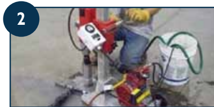
2 Les installateurs certifiés utilisent de l'équipement spécialisé pour forer les trous.
